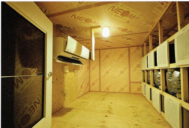
小屋裏には、エアコン1台で家中の温度を管理できる空調室が。扉(写真左)にもフィルターを取り付け、家中にクリーンな空気を送れる仕組みになっている。
